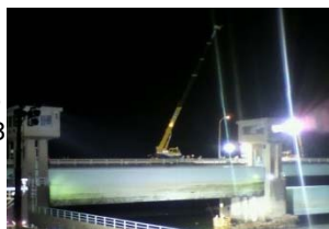
高瀬堰作業現場
