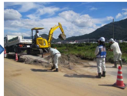
ホースブリッジ撤去作業
