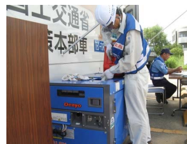
発動発電機給油作業
