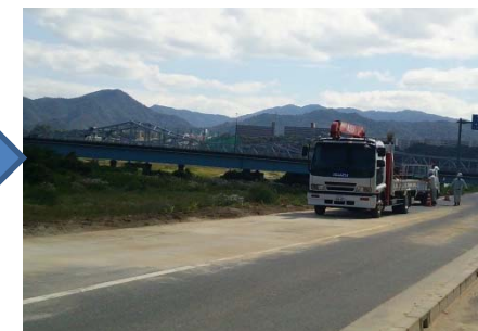
ホースブリッジ撤去終了
