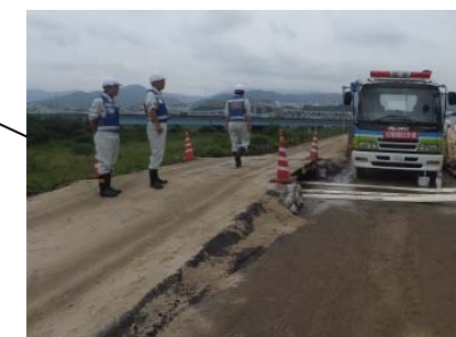
ホースブリッジの確認
