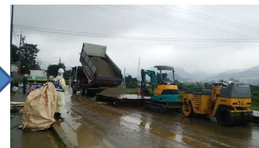
擦り付け部施工
