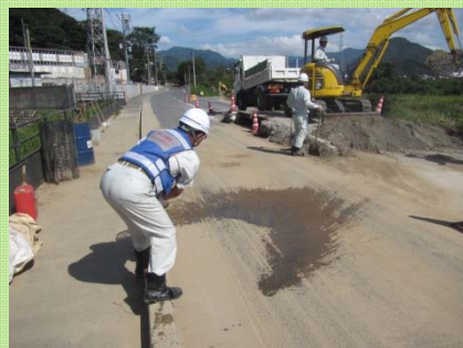
民家が近く、防塵のための散水
