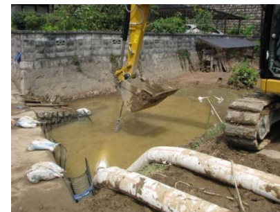
堆積土掘削状況
