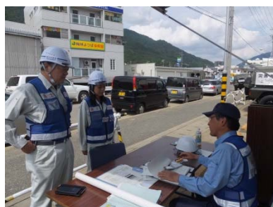
TEC-FORCE隊員への稼働状況確認
