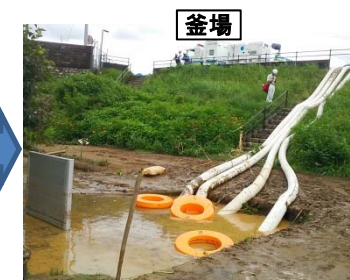
設置完了確認
