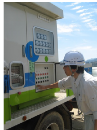
排水ポンプ車の操作確認
