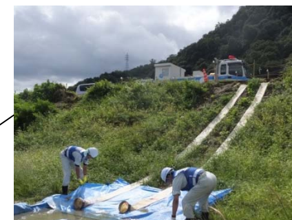
ポンプ吐き出し口の確認
