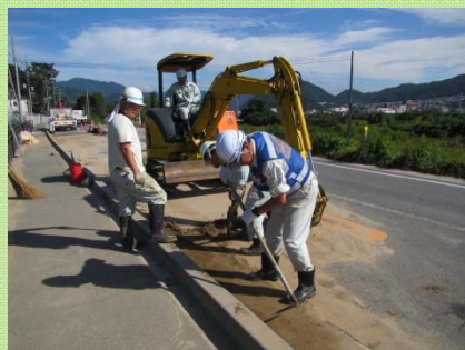
ポンプ車撤去後の堆積土砂清掃
