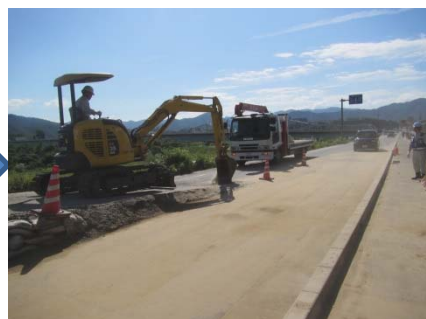
排水ポンプ車撤去 通行車線変更
