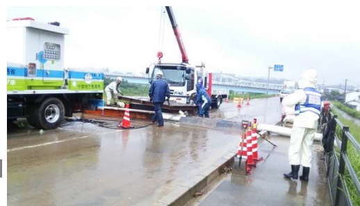
H型鋼・覆工版設置
