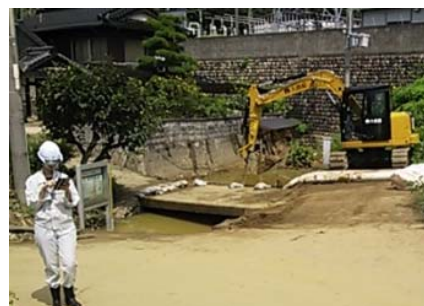
施工状況確認
