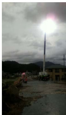
根の川作業現場
