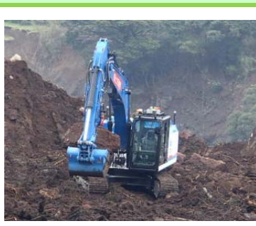
分組BH 稼働状況
