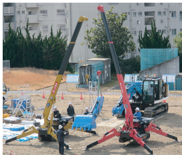
小型式クローラクレーンによる分解組立型バックホウの組立状況
