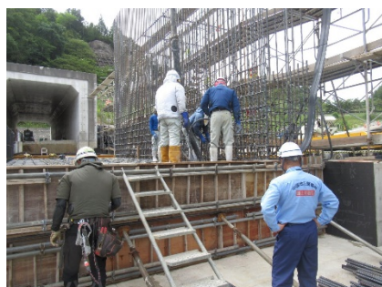
打込み・締固め確認
