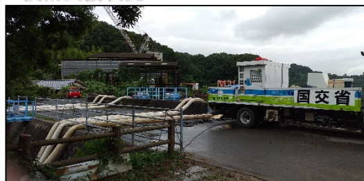
広島県豊田郡大崎上島町：排水作業
