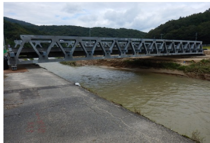
平成30年7月豪雨 岡山県矢掛町旧道古屋谷線古屋谷橋が被災、車両通行不可となり、矢掛町の要請により、応急組立橋を無償貸与し、10月に供用開始
