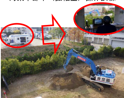
分解組立型バックホウ 遠隔操作 操縦訓練
