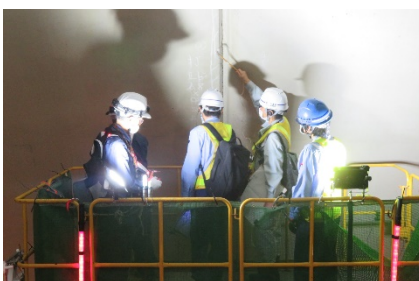
（トンネル管理実務者Ⅰ研修） トンネル点検 現地演習
