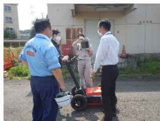
路面下空洞探査
