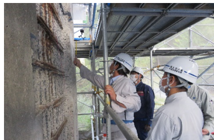
（橋梁管理実務者Ⅱ研修） 橋梁補修工事 現場見学
