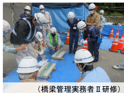
（橋梁管理実務者Ⅱ研修） 橋梁補修工事 現場見学
