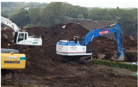
平成28年4月熊本地震 熊本県阿蘇郡南阿蘇町 阿蘇大橋崩落箇所にて遠隔操縦（無人化施工）による土砂撤去作業を実施
