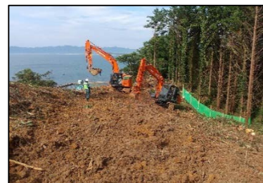
島根県出雲市：遠隔操縦装置による作業
