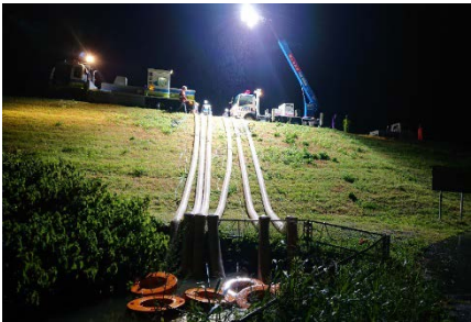
令和2年7月豪雨 福岡県みやま市等に排水ポンプ車3台、照明車1台を派遣
