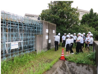
ボックスカルバート 施工不良モデル
