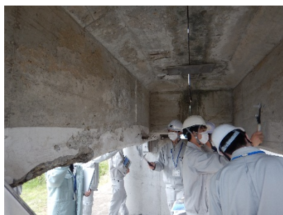
打音点検の体験（広島市）
