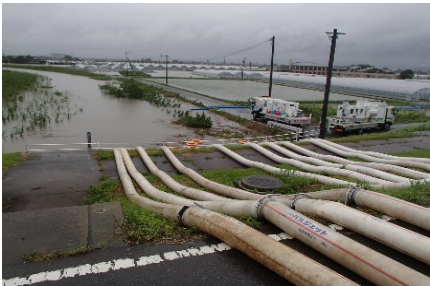
令和2年7月豪雨 福岡県久留米市に、排水ポンプ車1台を派遣 (九州地整と合同作業を実施)
