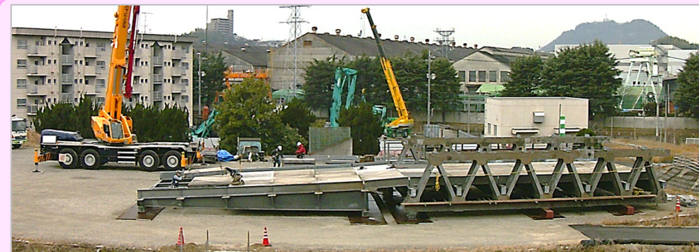
応急組立橋架設点検【協定会社】
