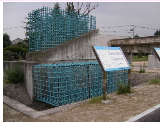
函渠モデルの説明(自治体職員) 現場施工の工程と、施工不良（鉄筋かぶり不良、コールドジョイント等）のモデルを展示
