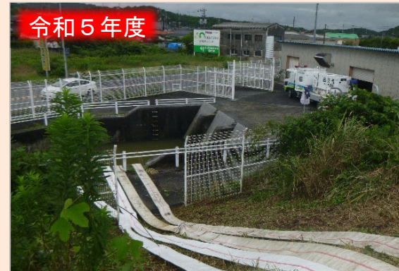
令和5年7月大雨(山口県宇部市) 排水ポンプ車派遣
