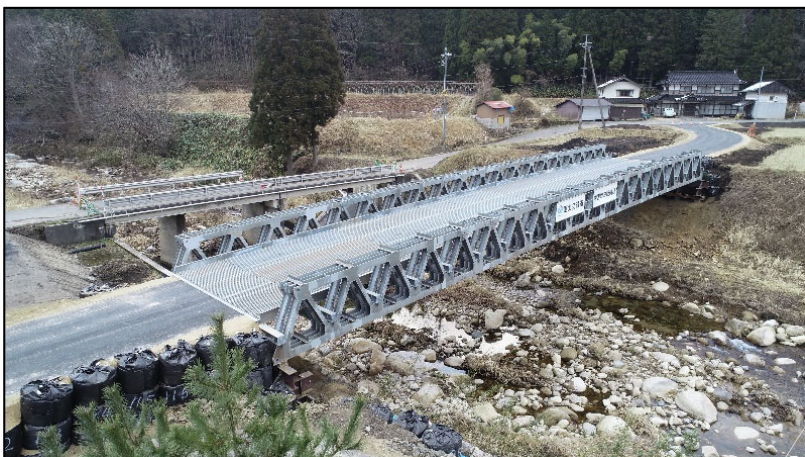
岡山県鏡野町の応急組立橋
