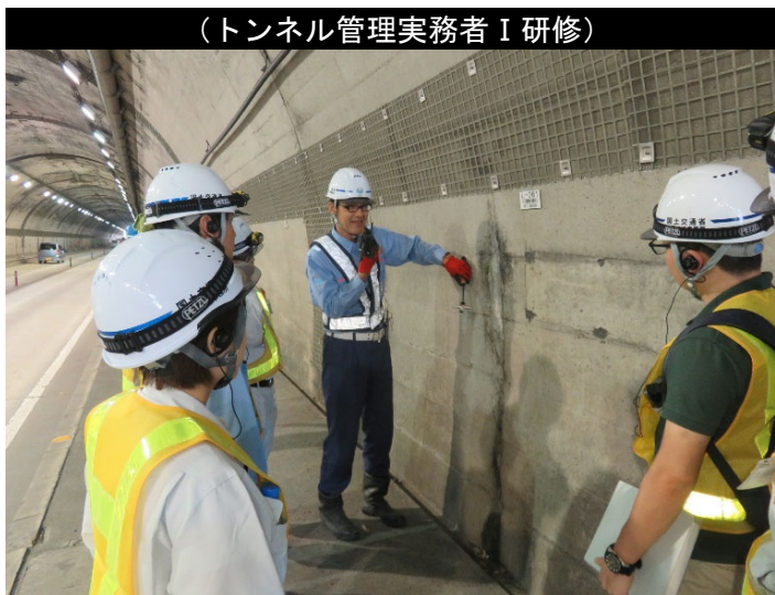
構造物点検実習
