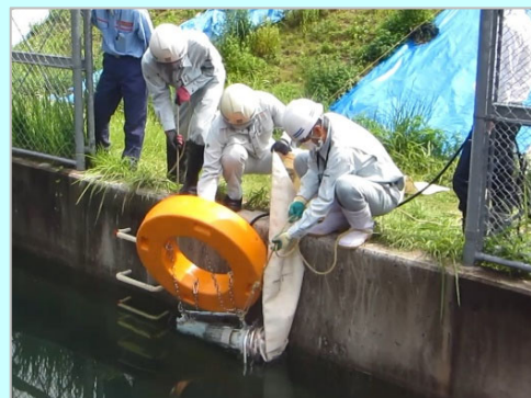
排水ポンプ車操作訓練【協定会社】
