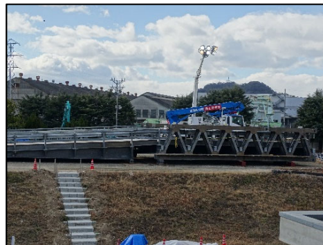
構内の応急組立橋
