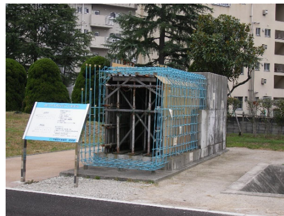
橋梁下部工・橋脚モデルの説明（自治体職員） 橋脚の躯体・フーチングの実際の配筋状況を再現したモデルを展示
