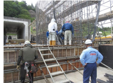
打込み・締固め確認
