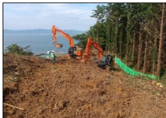
島根県出雲市①：遠隔操縦装置による作業
