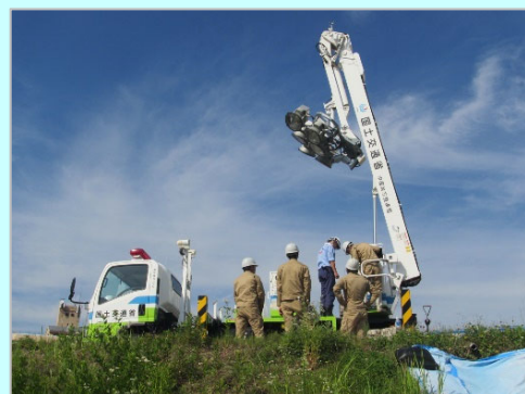
照明車操作訓練【協定会社】
