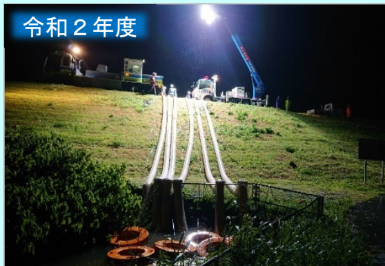
令和2年7月豪雨(福岡県みやま市ほか) 排水ポンプ車・照明車派遣
