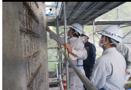
橋梁補修工事 現場見学
