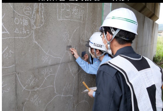
橋梁点検 現地演習
