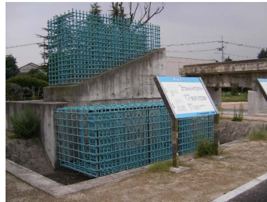
函渠モデルの説明(自治体職員) 現場施工の工程と、施工不良(鉄筋かぶり不良、コールドジョイント等)のモデルを展示
