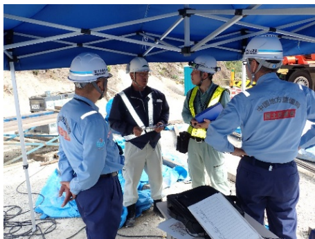
施工実態ヒアリング
