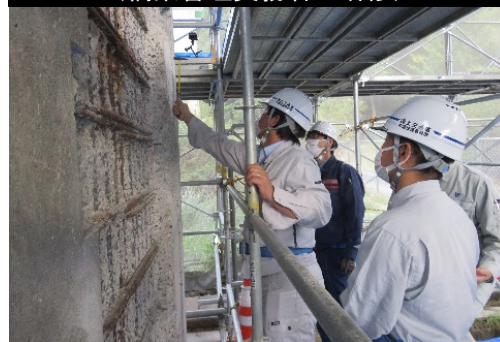
橋梁補修工事 現場見学
