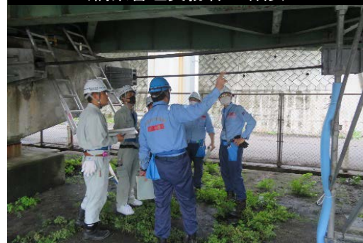
橋梁点検 現地演習
