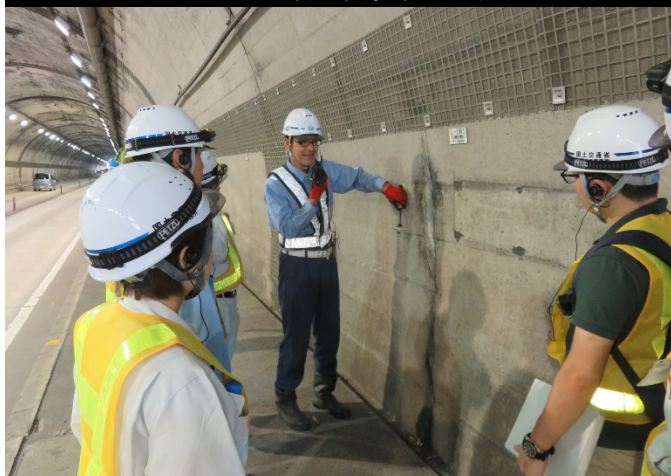
構造物点検実習
