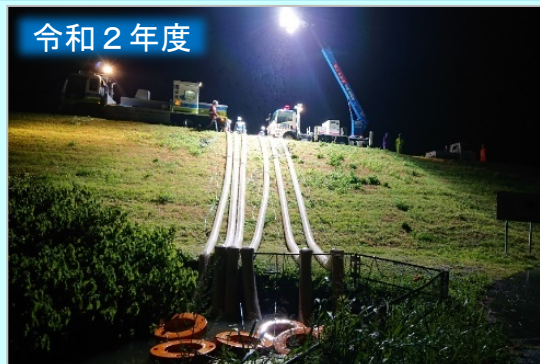
令和2年7月豪雨(福岡県みやま市ほか) 排水ポンプ車・照明車派遣
