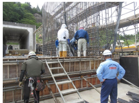
打込み・締固め確認
