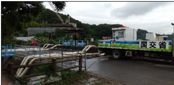
広島県豊田郡大崎上島町：排水作業
