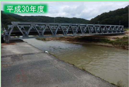
平成30年7月豪雨(岡山県矢掛町) 矢掛町要請 応急組立橋無償貸与
