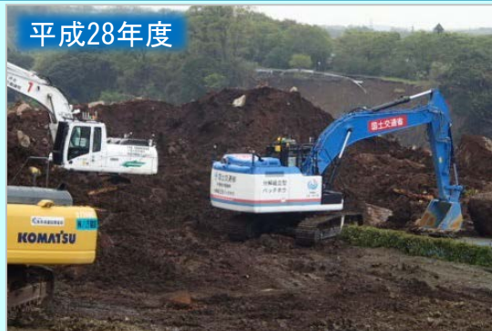
平成28年熊本地震(熊本県南阿蘇町) 分解組立型バックホウ派遣
