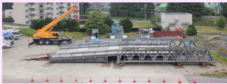
応急組立橋架設点検【協定会社】
