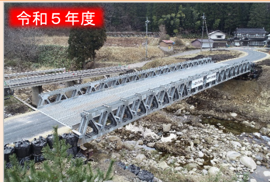
令和5年台風7号(岡山県鏡野町) 鏡野町要請 応急組立橋無償貸与
