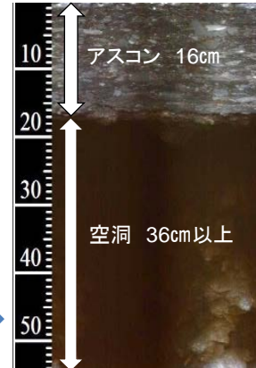
▲ボーリング調査の断面映像
