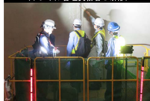
トンネル点検 現地演習
