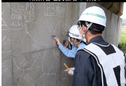
橋梁点検 現地演習
