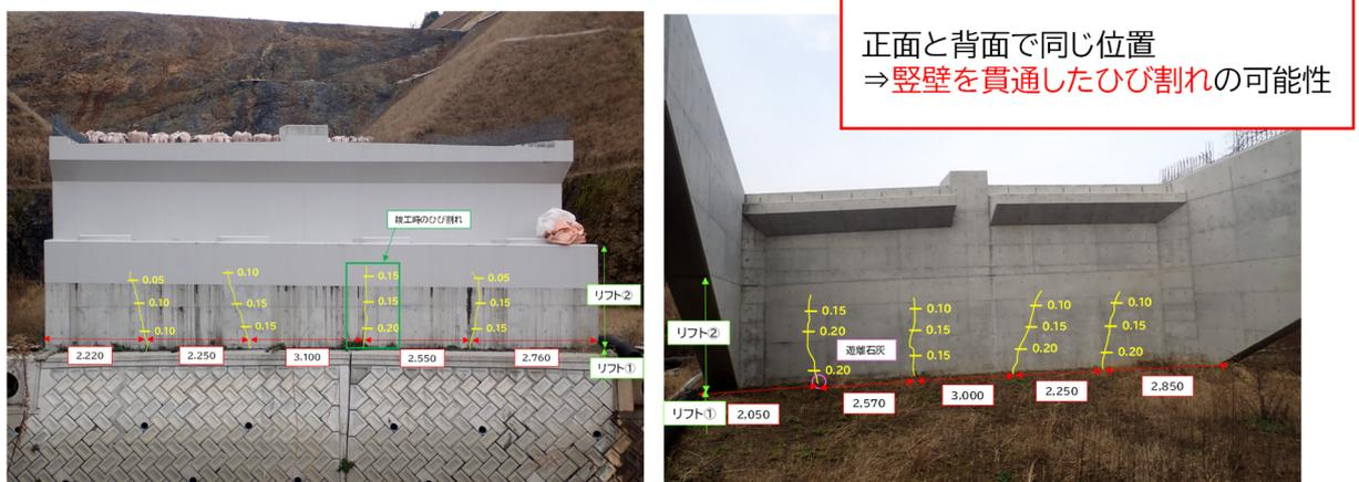
図 1.1 設計段階で照査しなかったコンクリート構造物のひび割れ発生事例
