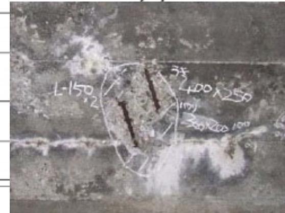
かぶり厚不足による剥離・鉄筋露出
