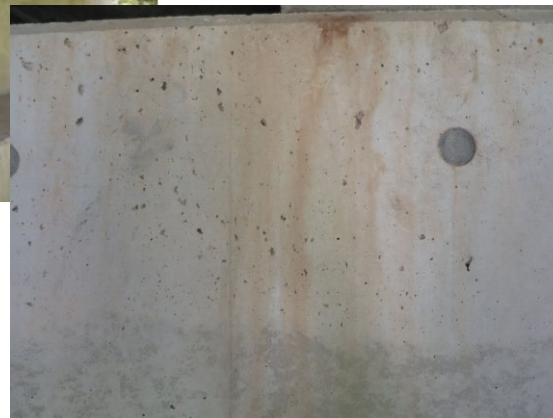
充填不良による表面気泡
