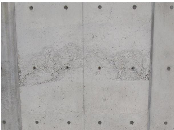
※充填不良による豆板は施工上の不備だけでなく、材料の不備によっても発生する可能性がある。
