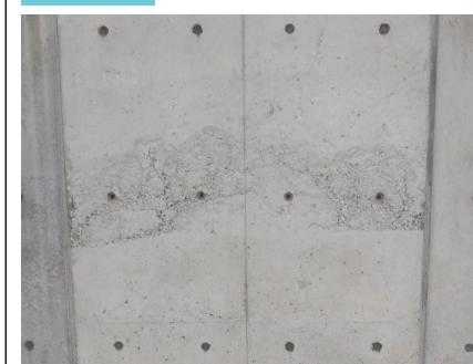
※充填不良による豆板は施工上の不備だけでなく、材料の不備によっても発生する可能性がある。
