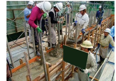
図 施工者によるコンクリート締固め確認状況
