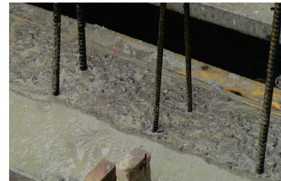
図 打継ぎ処理部の給水例 9)
