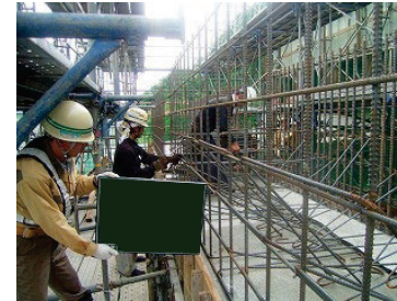
図 施工者による鉄筋組立確認状況
