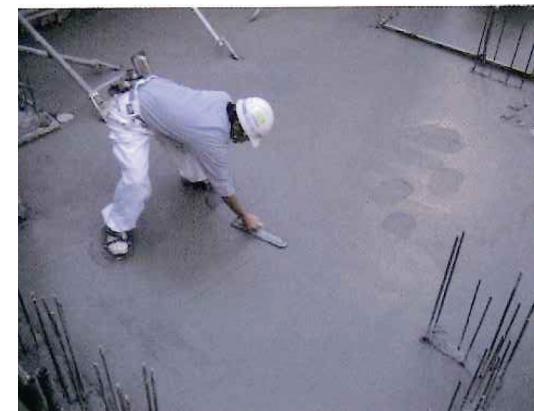
図 仕上げ作業状況の例
