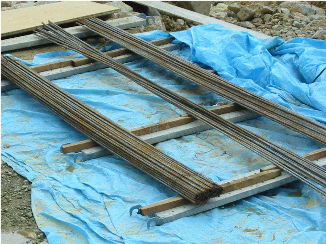
写真 3-1 鉄筋が地面と接しないような処置
