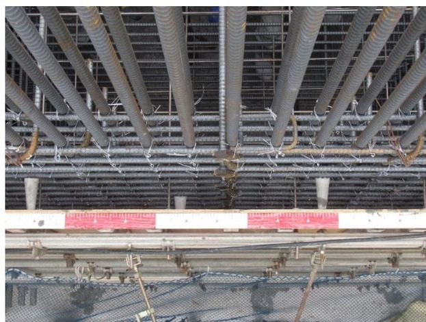
写真 7-1 型枠天端に挿入間隔確認のためのリボンネット設置例
