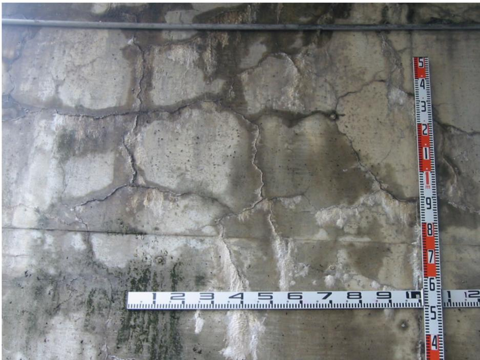
写真 2-2 アルカリシリカ反応による劣化例
