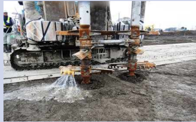
新型攪拌翼とエジェクター吐出口
