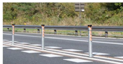
設置状況(昼間)
