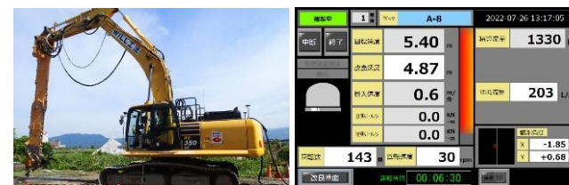
施工機械全景
