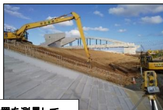
刃先の位置を測量して 設計面との差を確認
