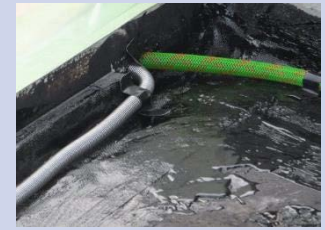
導水管設置例
