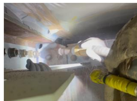
ショットピーニング施工状況
