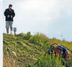
除草作業状況
