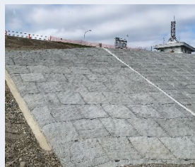
護岸ブロック
