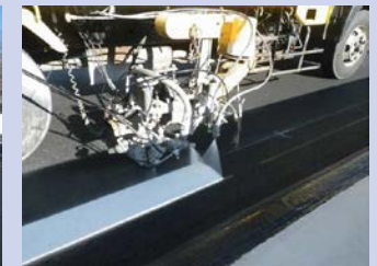
施工状況接写
