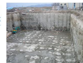
改良体出来形
