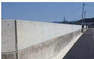
コンクリート防潮壁
