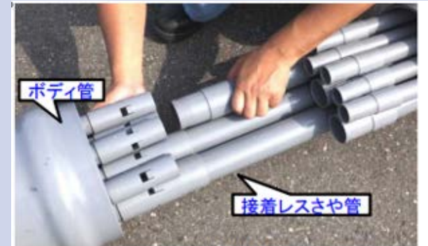
ボディ管内さや管接続作業
