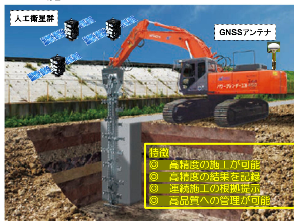
中層混合処理工 トレンチャ式
