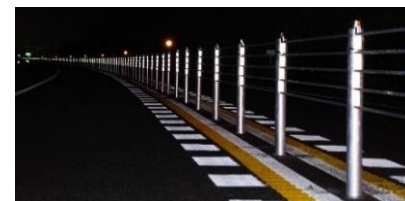
設置状況(夜間)
