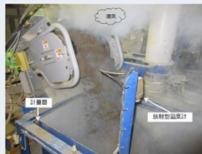
蒸気による骨材の加温状況
