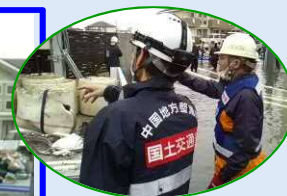
ポンプの設置場所と排水する場所などを打合せ中。
