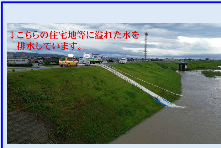
みやま市での排水ポンプ車による排水作業
