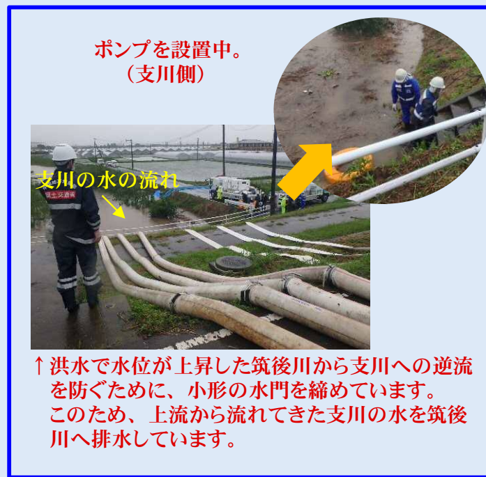
久留米市での排水ポンプ車による排水作業 (九州地方整備局の排水ポンプ車と合同作業)
