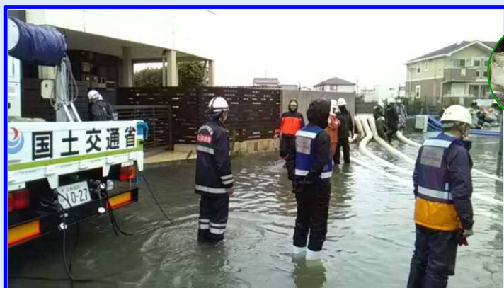
大牟田市での排水ポンプ車による排水作業 (九州地方整備局の排水ポンプ車と合同作業)
