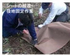
③ 遮光(防草シート)
