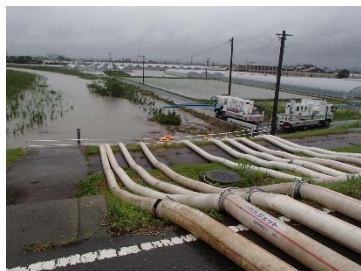
福岡県久留米市：筑後川排水作業
