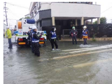
福岡県大牟田市：諏訪川排水作業
