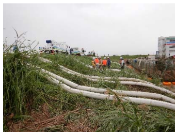
埼玉県川越市：小畔川排水作業状況
