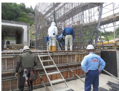
打込み・締固め確認
