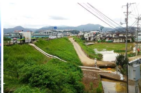
平成26年8月広島豪雨災害 安佐南区八木地内に排水ポンプ車を派遣
