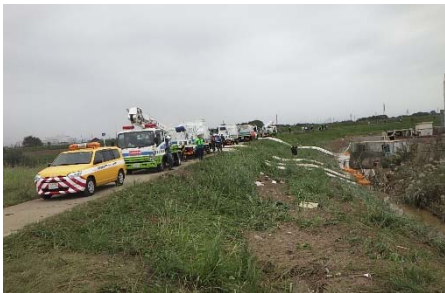
令和元年台風19号 埼玉県東松島市等に排水ポンプ車5台、照明車3台、対策本部車1台を派遣
