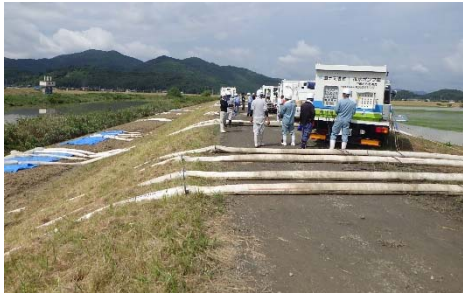
令和元年8月の前線に伴う大雨 埼玉県武雄市等に排水ポンプ車5台、照明車3台、対策本部車1台を派遣
