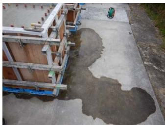
透水性型枠からの排水状況
