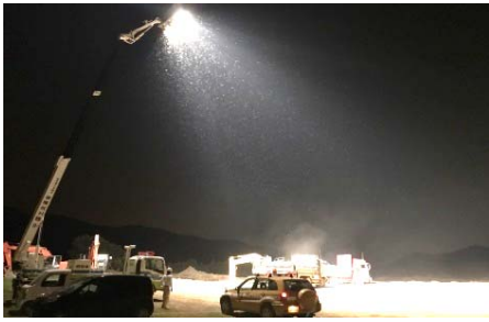
平成30年7月豪雨 岡山県倉敷市等に排水ポンプ車、照明車等を派遣
