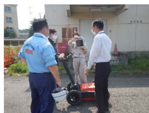
路面下空洞探査
