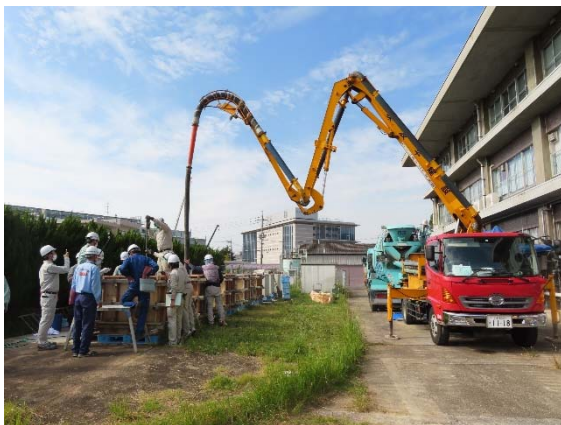
供試体作成(ポンプ打設)
