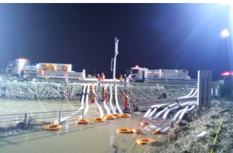
平成27年9月関東・東北豪雨災害 茨城県常総市等に排水ポンプ車、照明車を派遣
