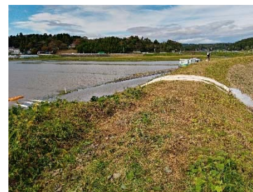
宮城県大崎市：小迫川排水作業
