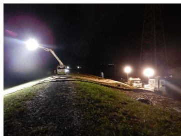
埼玉県東松山市：越辺川排水作業
