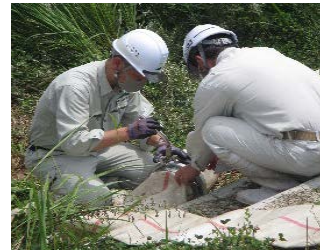
R3訓練状況（排水ポンプ車）
