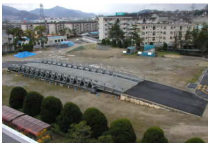
応急組立橋梁
