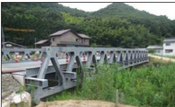
平成 30 年 9 月派遣を行った応急組立橋状況 (岡山県小田郡矢掛町)
