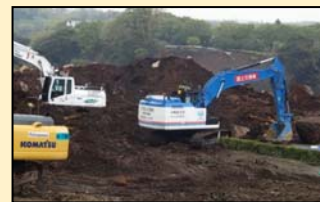
● H28年4月 熊本地震(熊本県阿蘇郡南阿蘇村) 阿蘇大橋崩落箇所にて遠隔操縦(無人化施工)による土砂撤去作業を実施。
