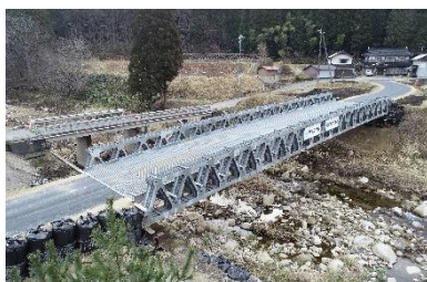
令和5年8月台風7号 活動状況 (岡山県内：応急組立橋)
