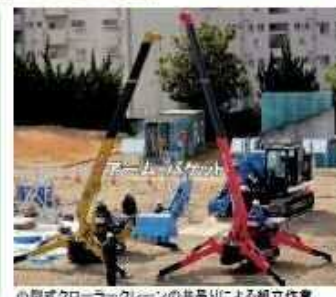
小型式クローラークレーンの共吊りによる組立作業
