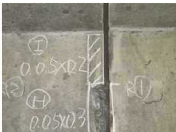
③横梁部のうき、はく離(鉄筋露出)
