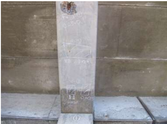
③横梁部のうき、はく離(鉄筋露出)
