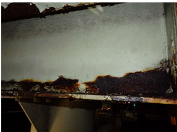
③床版部デッキプレートの腐食
