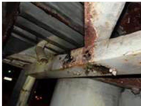
⑥排水樋部の腐食
