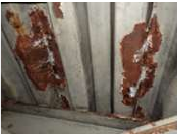
⑤階段蹴上げ部の腐食
