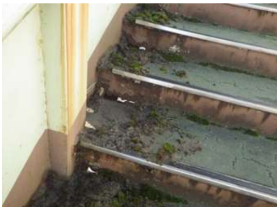
⑤階段蹴上げ部の腐食
