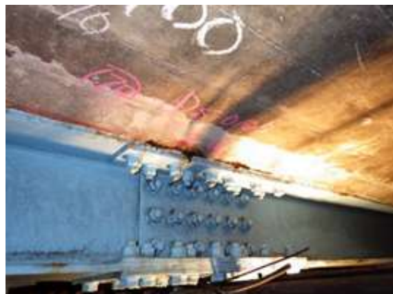
⑥排水樋部の腐食
