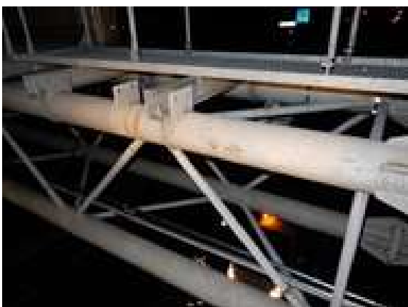
⑤支柱基部の腐食
