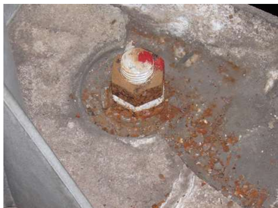
⑥支柱基部のボルトの腐食
