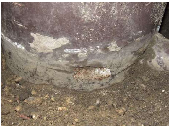
⑤支柱基部の腐食
