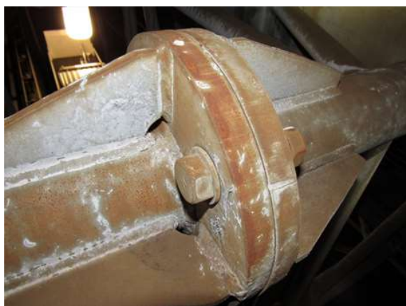
⑥支柱基部のボルトの腐食
