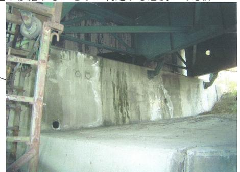
アルカリ骨材反応によるひびわれ
