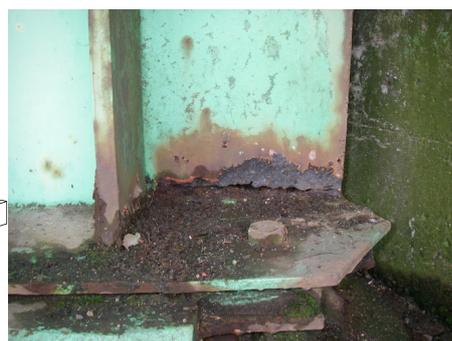
伸縮装置部からの漏水の影響による主桁端部の腐食
