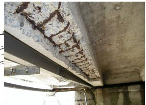
塩害により主桁に発生した剥離・鉄筋露出
