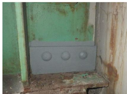
主桁の支点上のウェブや下フランジに減肉や断面欠損が見られ、上部工反力の伝達に支障が生じている可能性が高い。
