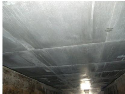
鉄筋が破断しており、補修では耐荷力の回復が見込めない。
