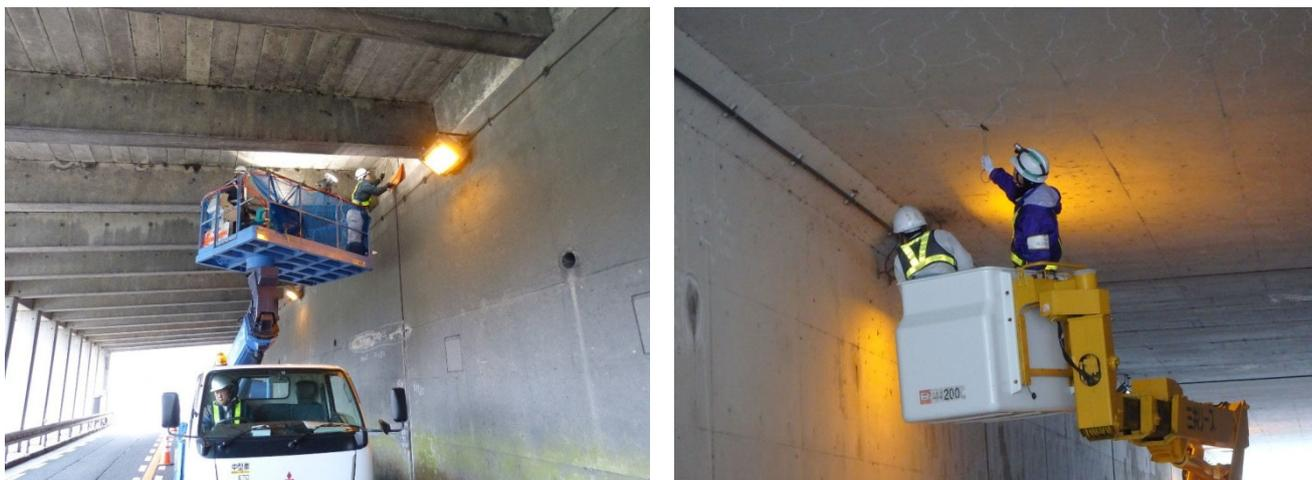
点検は、近接目視に加え必要に応じて触診や打音等の非破壊検査を実施します。
