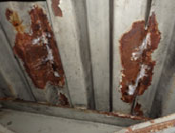
⑤階段蹴上げ部の腐食
