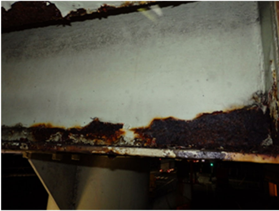
③床版部デッキプレートの腐食
