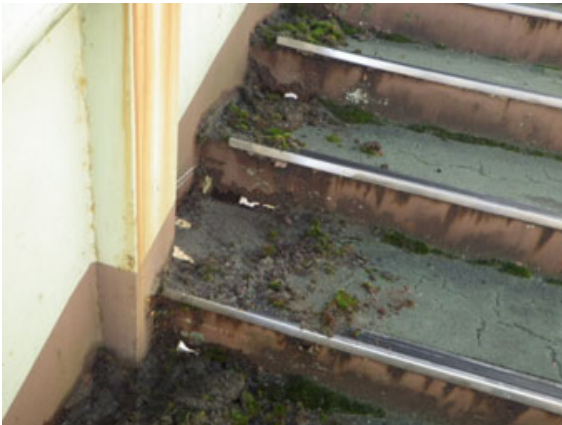
⑤階段蹴上げ部の腐食
