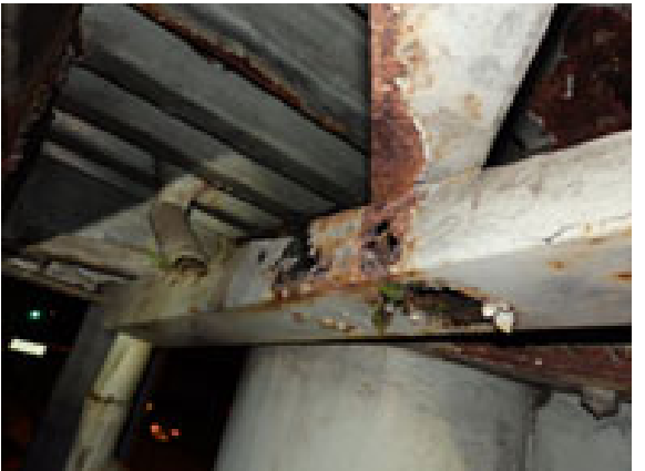
⑥排水樋部の腐食
