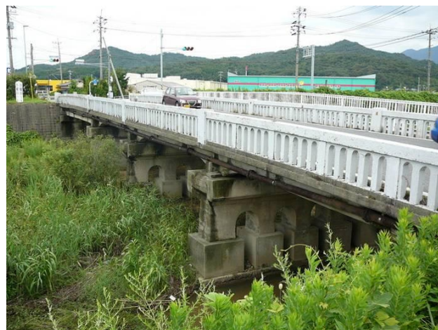
国道191号 葉中橋(山口県下関市豊浦町) (1932年完成 供用年数92年)
