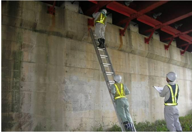
(梯子による定期点検)
