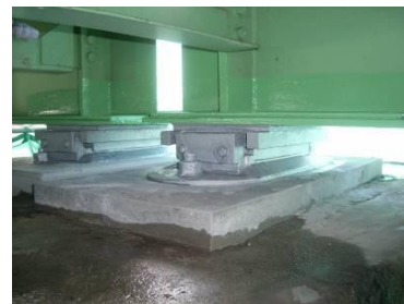
対策後(修繕実施)
