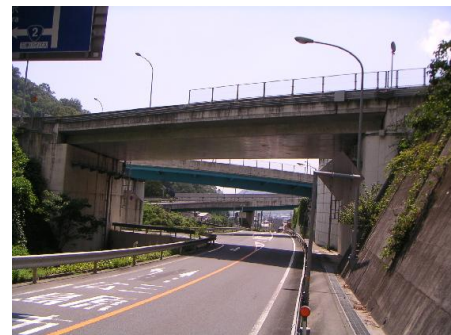
国道2号 恵下谷橋
