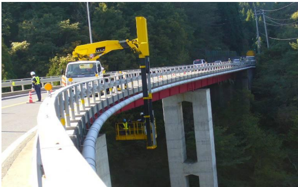
(橋梁点検車による定期点検)
