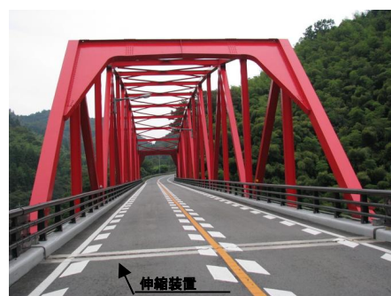
国道9号 東津和野大橋
