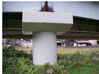
対策後(修繕実施)
