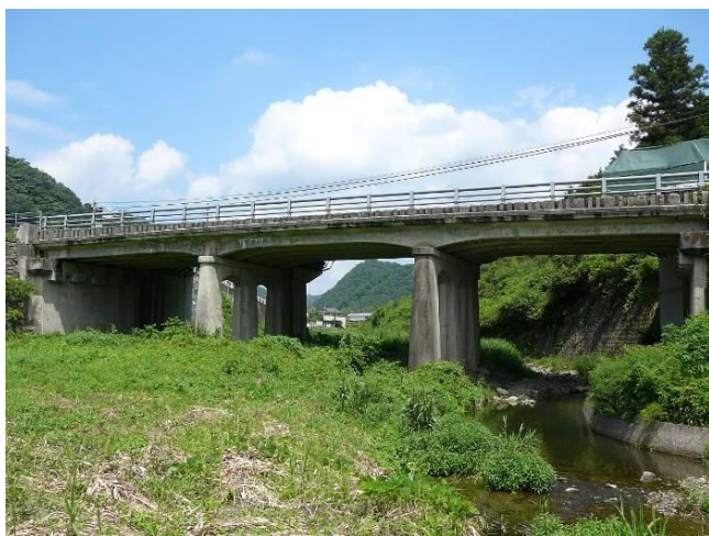
国道53号 白石橋(岡山市建部町) (1936年完成 供用年数88年)
