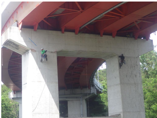
(ロープアクセスによる定期点検)
