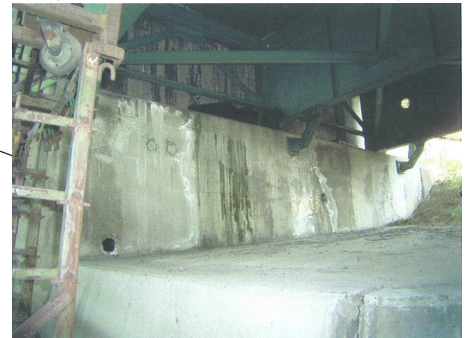
アルカリ骨材反応によるひびわれ
