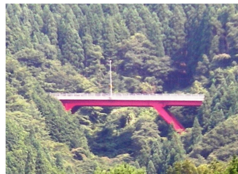
国道53号 杉見橋
