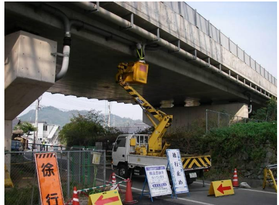
(高所作業車による定期点検)
