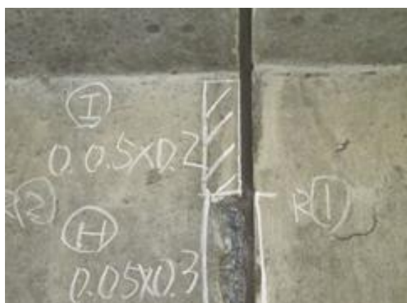
③横梁部のうき、はく離(鉄筋露出)
