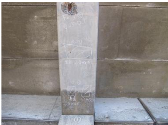
③横梁部のうき、はく離(鉄筋露出)
