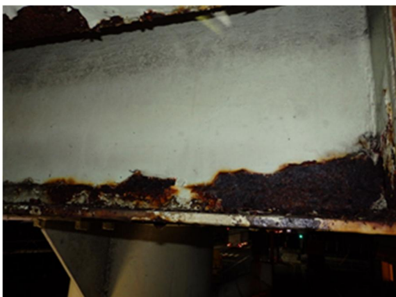
③床版部デッキプレートの腐食
