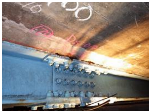
⑥排水樋部の腐食
