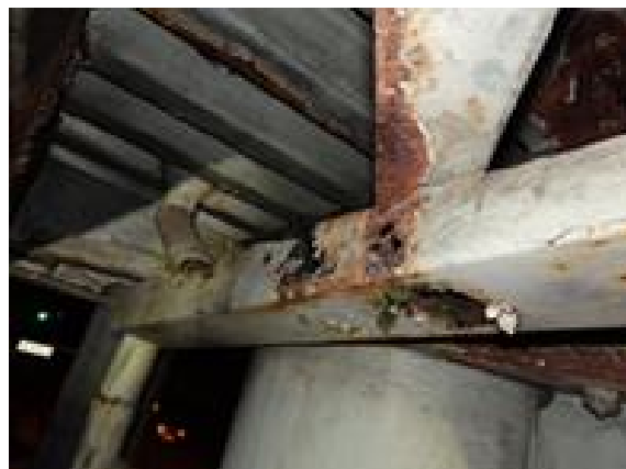
⑥排水樋部の腐食
