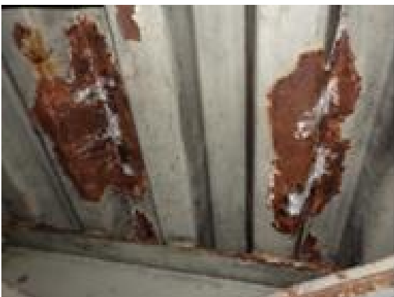
⑤階段蹴上げ部の腐食
