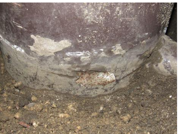
⑤支柱基部の腐食
