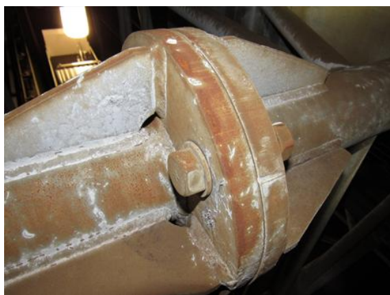
⑥支柱基部のボルトの腐食
