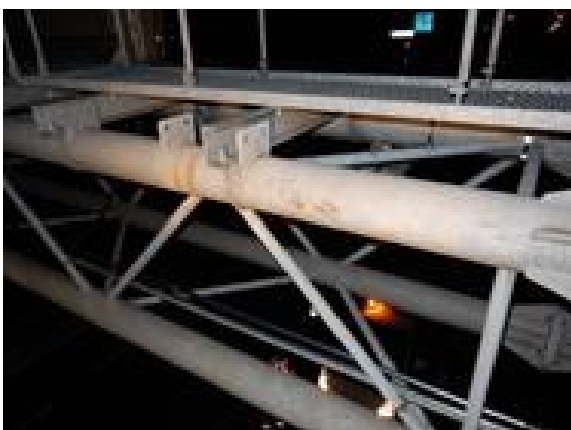
⑤支柱基部の腐食
