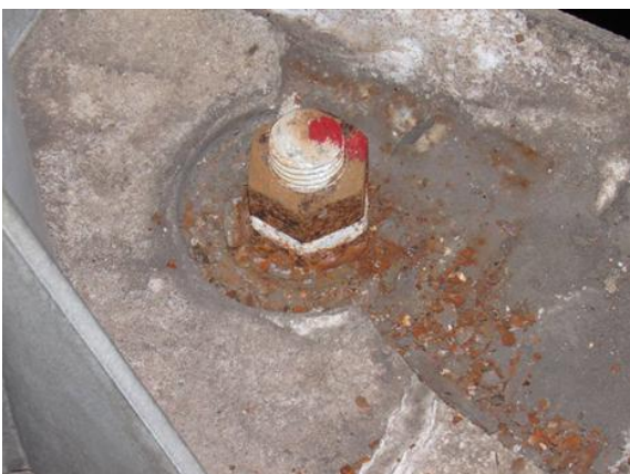
⑥支柱基部のボルトの腐食
