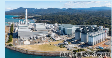
R4年11月2号機稼働
