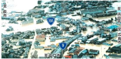
写真1 益田市内の浸水状況 (昭和58年豪雨)
