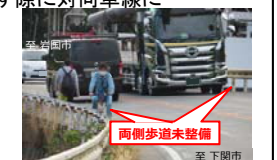
写真3 歩道未整備区間
