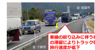
写真1 車線の絞り込みによる状況
