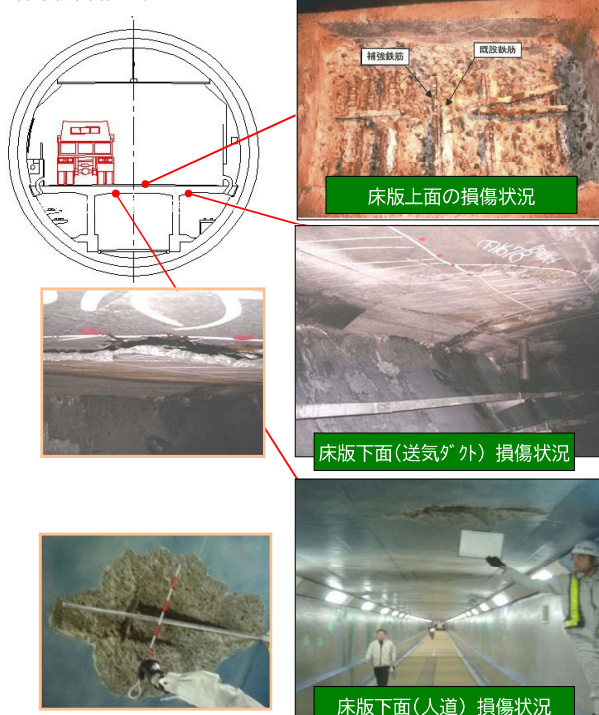
◆海底部床版取替前の状況
