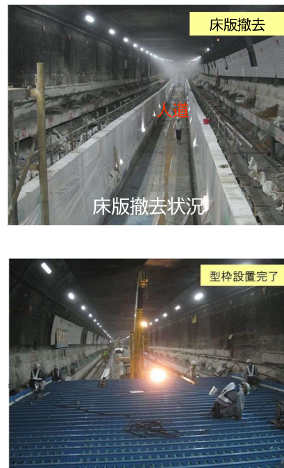
◆床版取替工事(海底部)の実施状況
