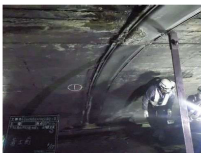
【漏水防止樋取替】
