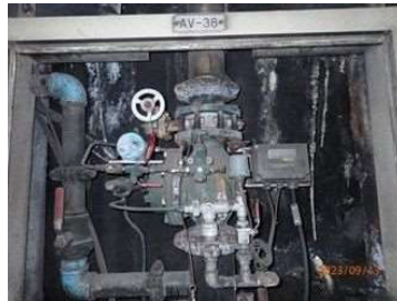
【非常用設備更新】
