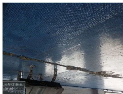
【料金所上屋構造物補修】
