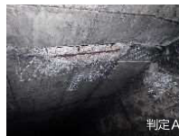
S 1 区間 床版下面の鉄筋露出
