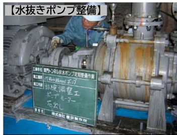
【水抜きポンプ整備】
