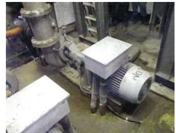
【排水ポンプ更新】
