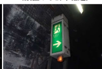
誘導標識 (設置から14年経過)
