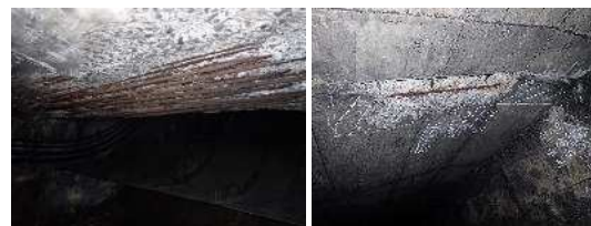
床版下面の鉄筋露出
