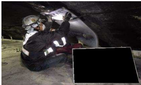
漏水防止シート取付
