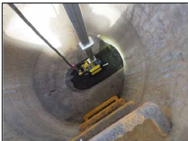
管口カメラ調査（広島市下水道局）
