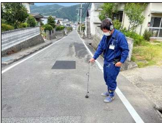
音聴調査状況 広島県水道広域連合企業団 三次事務所
