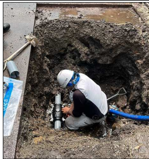
漏水修繕状況 広島県水道広域連合企業団 三次事務所
