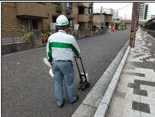
導管漏えい検査
