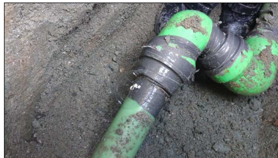
補修状況 広島市道(広島市)
