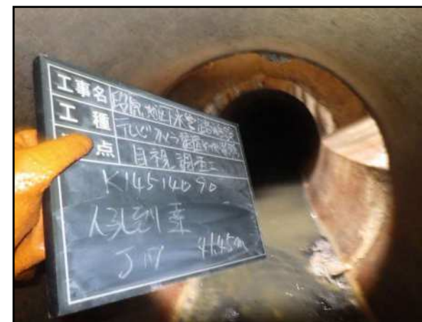
潜行目視調査（広島市下水道局）
