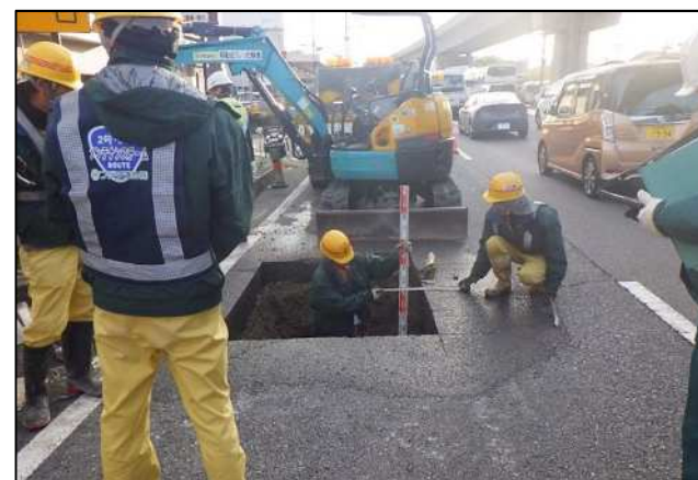
補修状況 国道54号（広島市）
