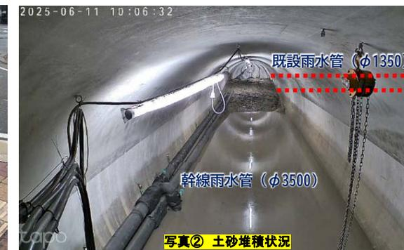
写真② 土砂堆積状況
