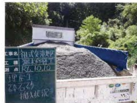
【祖式地区 漏水修繕工事 R6.10.10】
