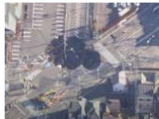
1月31日時点の事故現場の状況
