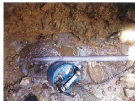
【祖式地区 漏水修繕工事 R6.10.10】
