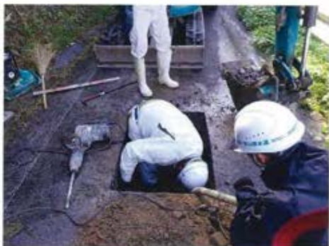
【祖式地区 漏水修繕工事 R6.10.10】
