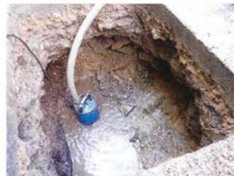
【祖式地区 漏水修繕工事 R6.10.10】
