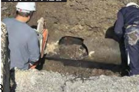
破損した水道管
