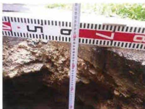
【祖式地区 漏水修繕工事 R6.10.10】
