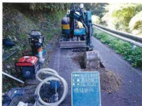
【祖式地区 漏水修繕工事 R6.10.10】
