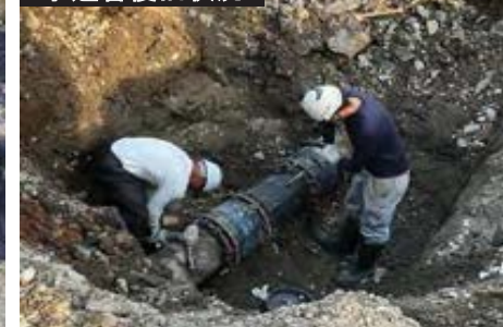
水道管復旧状況
