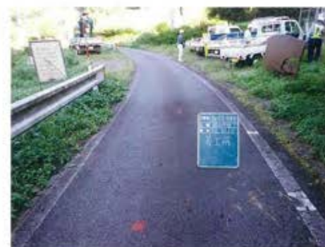
【祖式地区 漏水修繕工事 R6.10.10】
