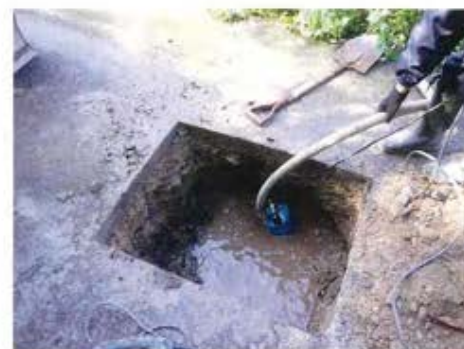
【祖式地区 漏水修繕工事 R6.10.10】
