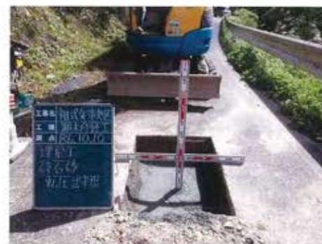
【祖式地区 漏水修繕工事 R6.10.10】
