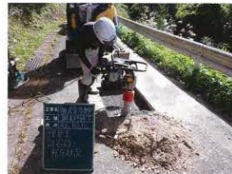
【祖式地区 漏水修繕工事 R6.10.10】
