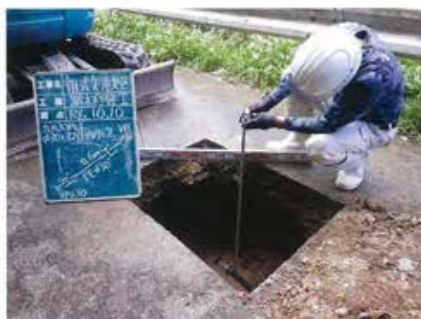
【祖式地区 漏水修繕工事 R6.10.10】
