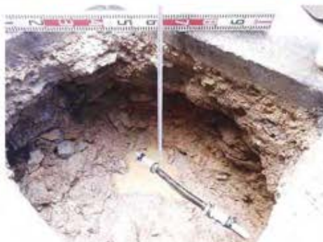
【祖式地区 漏水修繕工事 R6.10.10】
