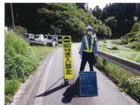
【祖式地区 漏水修繕工事 R6.10.10】
