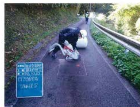
【祖式地区 漏水修繕工事 R6.10.10】
