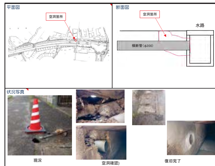
国道9号（島根県大田市）
