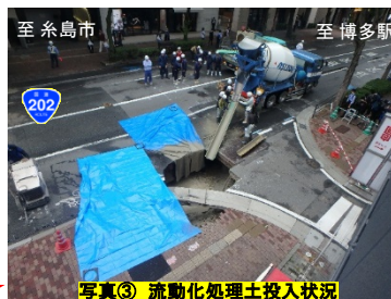
写真③ 流動化処理土投入状況
