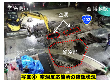
写真④ 空洞反応箇所の確認状況
