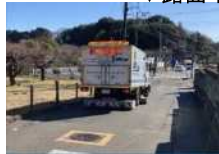
(空洞探査車による調査)
