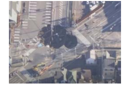
埼玉県八潮市の事故現場(令和7年1月31日)
