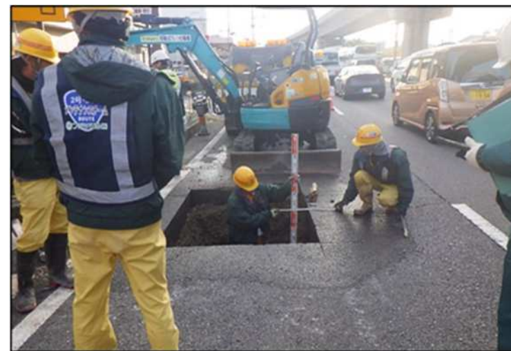
補修状況 国道54号（広島市）
