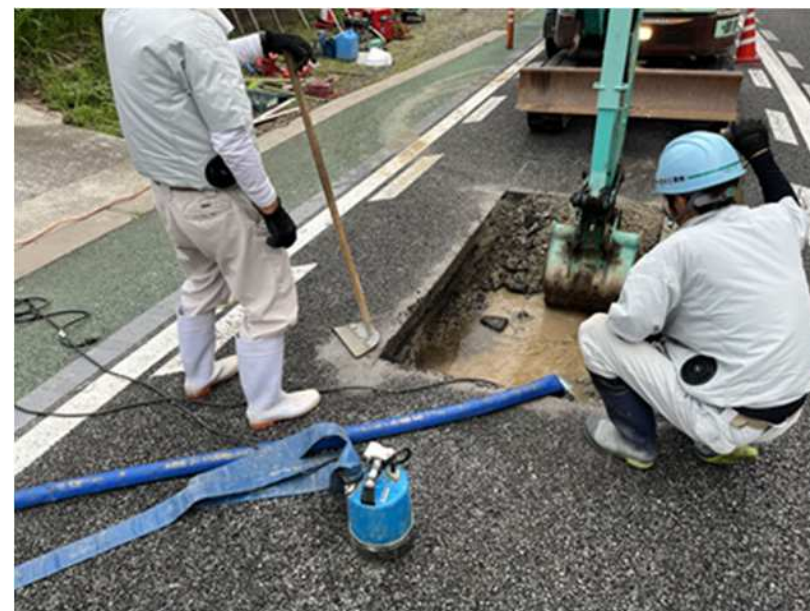
漏水修繕状況 広島県水道広域連合企業団 三次事務所
