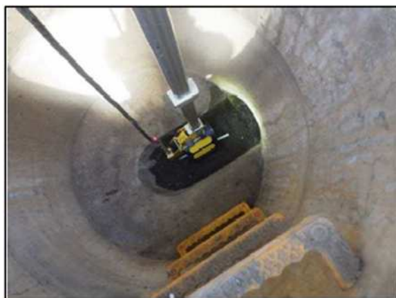
管口カメラ調査（広島市下水道局）
