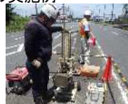
(貫入試験による調査)
