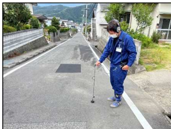
音聴調査状況 広島県水道広域連合企業団 三次事務所
