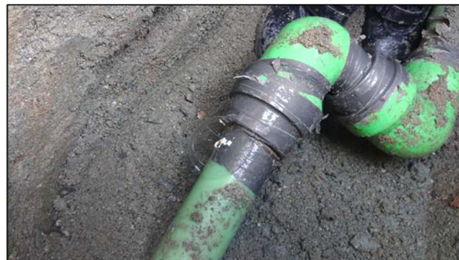
補修状況 広島市道(広島市)
