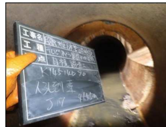
潜行目視調査（広島市下水道局）
