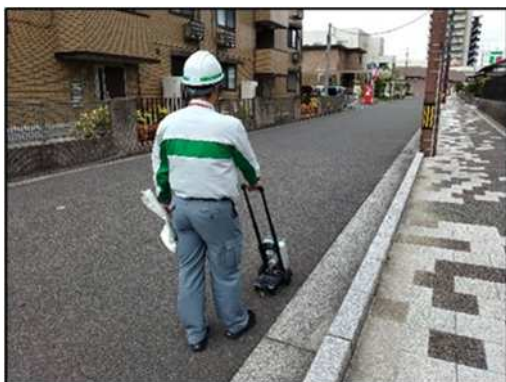
導管漏えい検査
