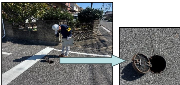
音調棒による漏水調査状況
