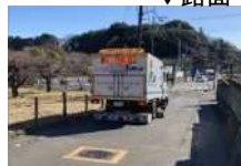
(空洞探査車による調査)
