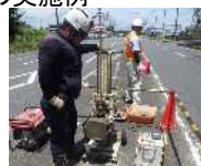
(貫入試験による調査)
