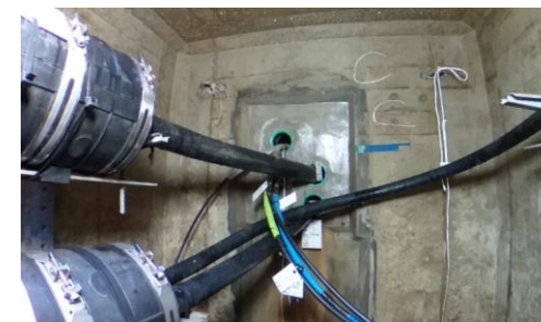
マンホール内写真
