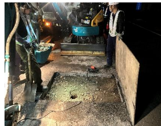
国道2号（岡山県岡山市）
