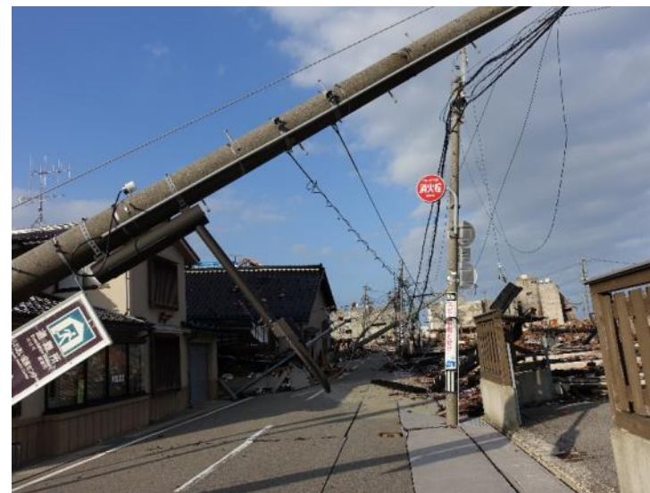
能登半島地震により倒壊した電柱
