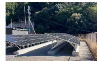
太陽光発電施設の設置
