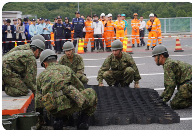
【橋梁段差部の修正工(自衛隊)】
