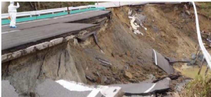
図 4-3 盛土崩壊のイメージ
