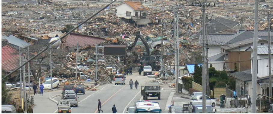
図 4-1 建物倒壊がれき・津波堆積物のイメージ
