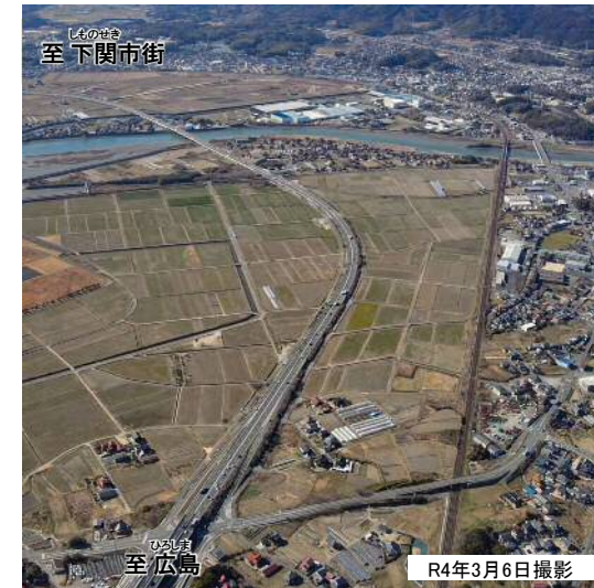
▲事業区間起点付近の状況（写真①）
