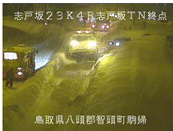
除雪作業状況
