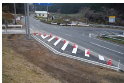
転回場の拡張整備 (鳥取自動車道 坂根交差点)
