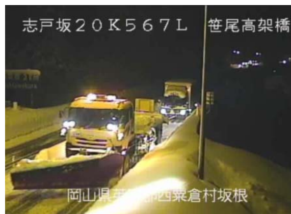
除雪車による牽引状況
