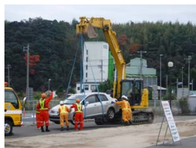
バックホウによる吊り上げ
